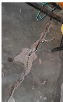
Vista de cocina, y detalle de grietas en paredes y piso.
