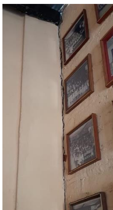
Vista de direccion, y detalle de grietas en paredes.
