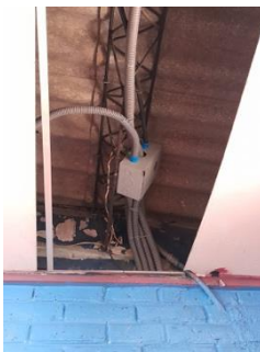
Detalle del mal estado del Sistema electrico en aulas
